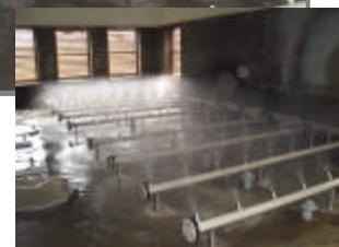
Bei der mechanischen Entsäuerung handelt es sich um ein Stoffaustauschverfahren, bei dem aufgrund eines treibenden Gefälles CO<sub>2</sub> aus dem zu behandelnden Wasser in der Luft als Gasphase übergeht. Nach dem Henry-Gesetz ist die Löslichkeit von Gas (CO<sub>2</sub>) in Wasser abhängig von dem Partialdruck, der Verweilzeit in der Luft und der Temperatur.
