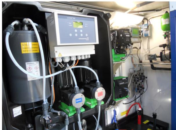
Dosierpumpen 16bar und 10bar
